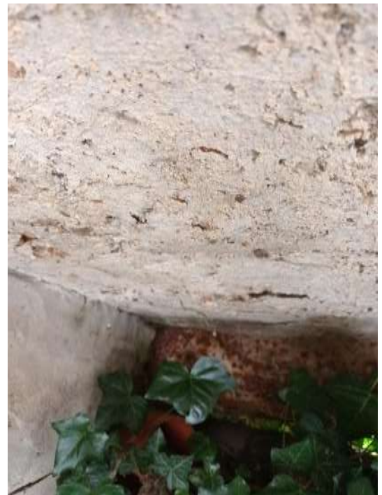
Figure 18 : Dessous de tablier avec éclatements de béton
