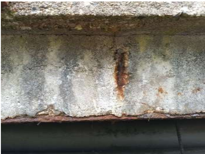
Figure 17 : Signes de corrosion sur le tablier de passerelle
