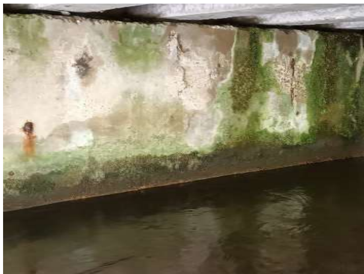
Figure 35 : Piles de passerelle en bon état général – quelques signes de corrosion
