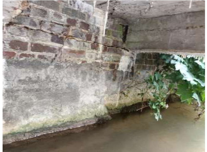
Figure 46 : Piles de passerelle fissurées + présence de végétation
