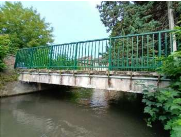
Figure 55 : Garde-corps en bon état
