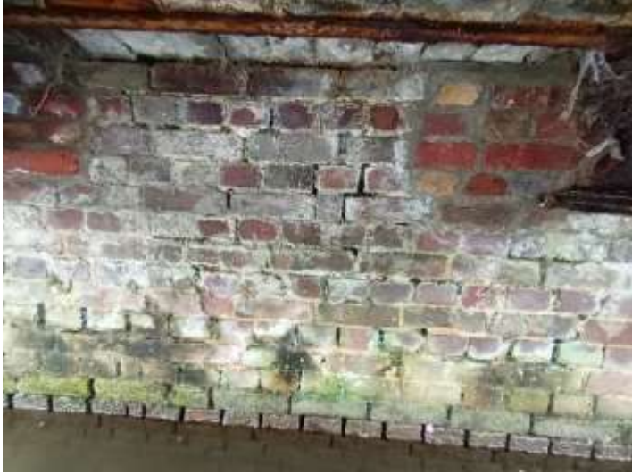
Figure 21 : Piles de passerelle abimées
