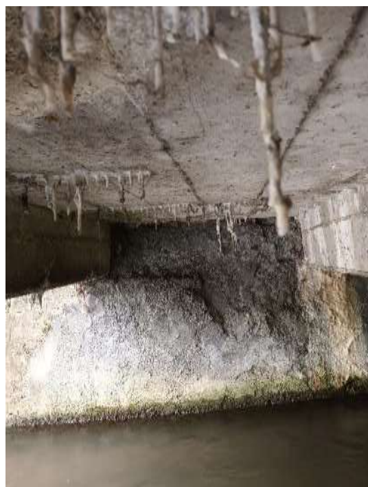
Figure 51 : Tablier en bon état général – présence de stalactites liés à la calcite
