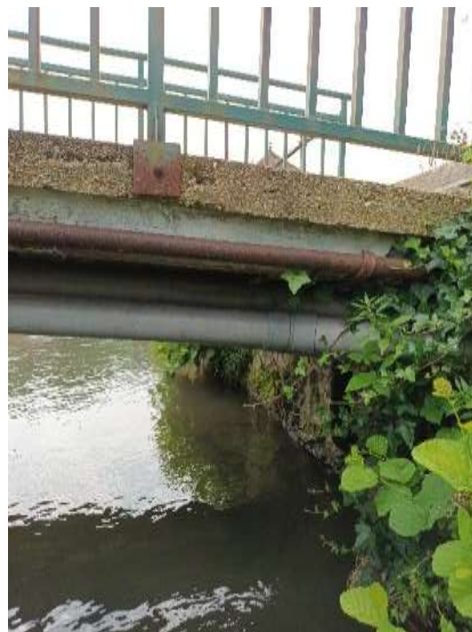
Figure 20 : Platines de garde-corps corrodés
