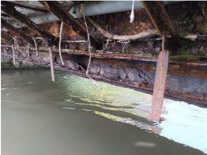
Figure 23 : Profilés fortement corrodés et arrivés à rupture
