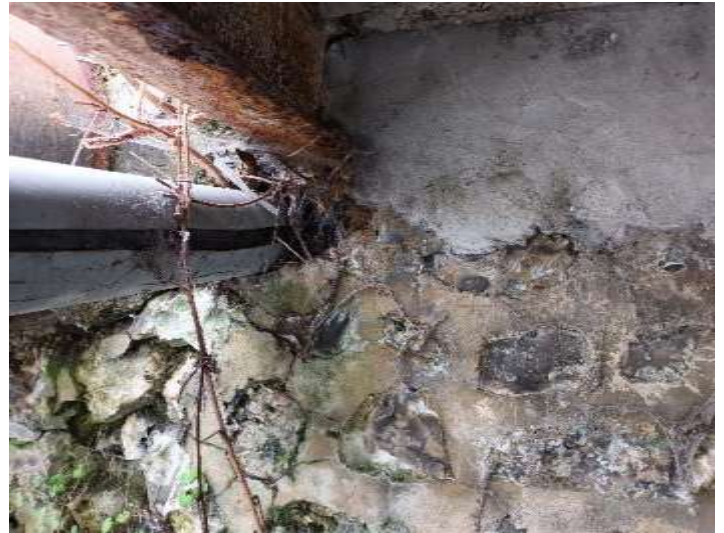
Figure 10 : Piles de passerelle abimées – traversée de réseaux
