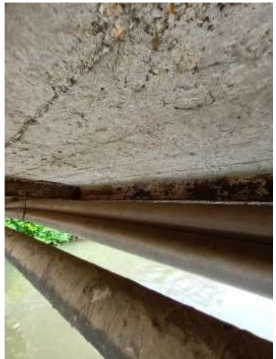
Figure 14 : Profilés corrodés et peinture écaillées
