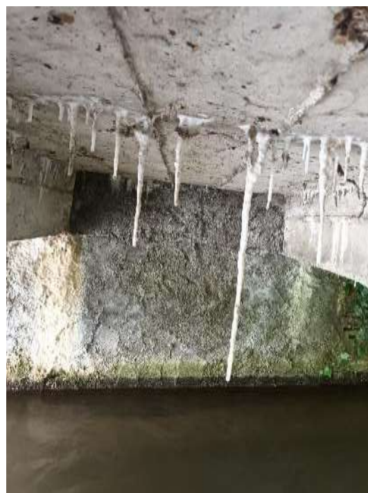
Figure 52 : Tablier en bon état général – présence de stalactites liés à la calcite
