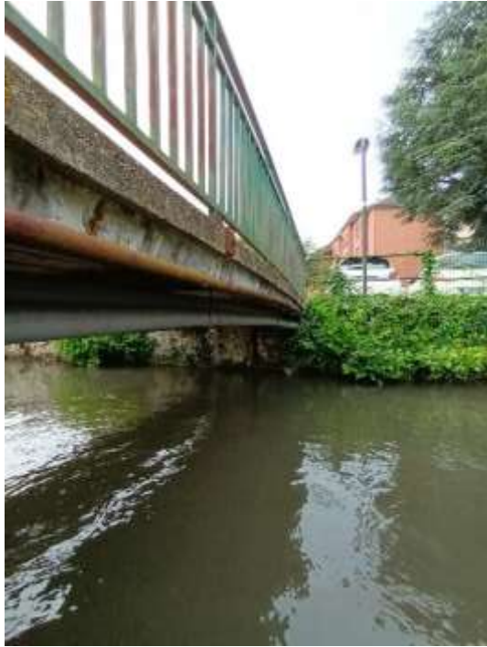
Figure 15 : Signes de corrosion sur le tablier de passerelle
