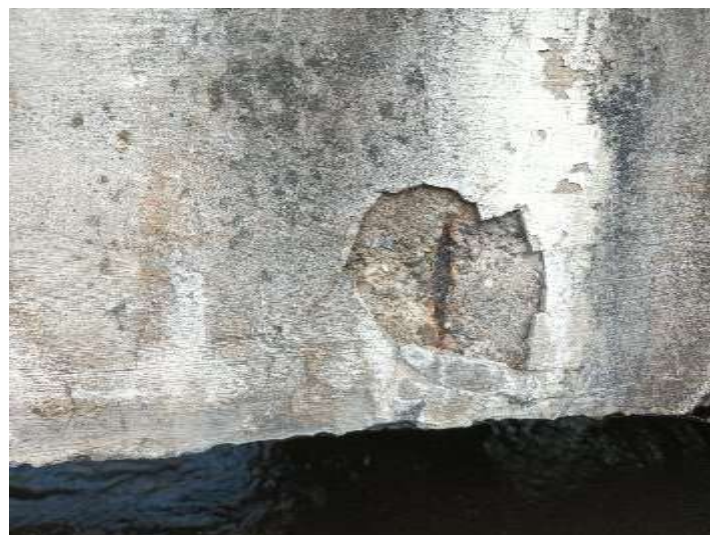
Figure 50 : Poutres en bon état général – présence d’aciers corrodés en rive
