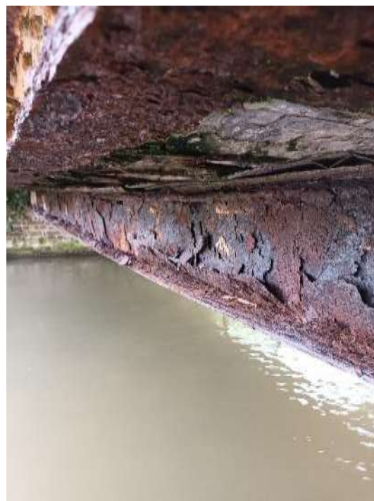
Figure 26 : Profilés fortement corrodés et arrivés à rupture – âme feuilletée
