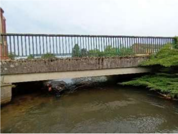
Figure 43 : Garde-corps en bon état
