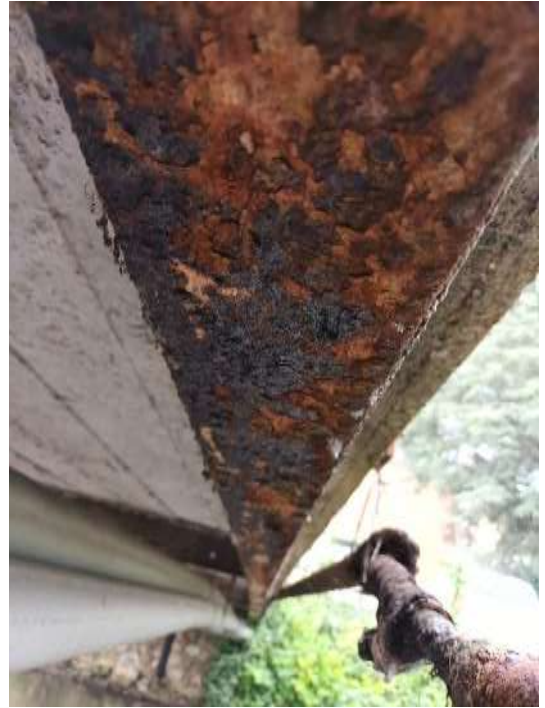
Figure 12 : Profilés corrodés et peinture écaillées
