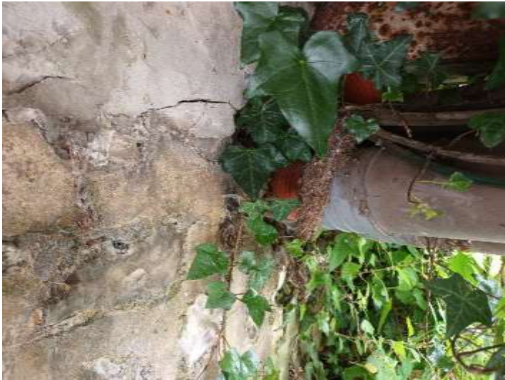
Figure 9 : Piles de passerelle abimées – traversée de réseaux
