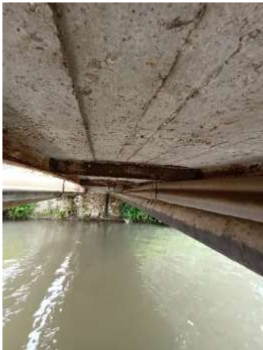
Figure 13 : Profilés corrodés et peinture écaillées
