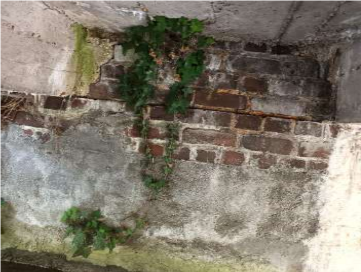
Figure 45 : Piles de passerelle fissurées + présence de végétation
