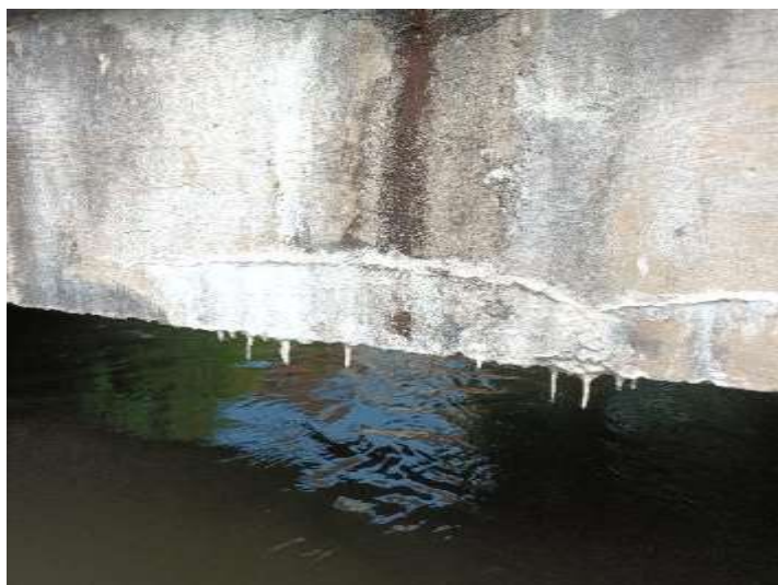
Figure 49 : Poutres de rive en bon état général – présence de stalactites liés à la calcite
