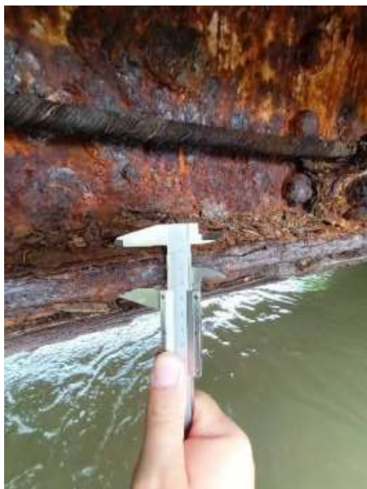
Figure 25 : Profilés fortement corrodés et arrivés à rupture – feuilletage de l’aile inférieure
