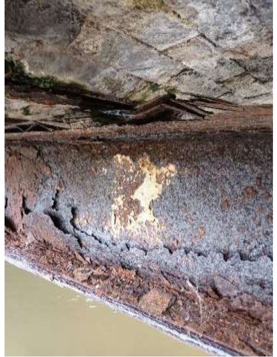
Figure 30 : Voutains brique déformés
