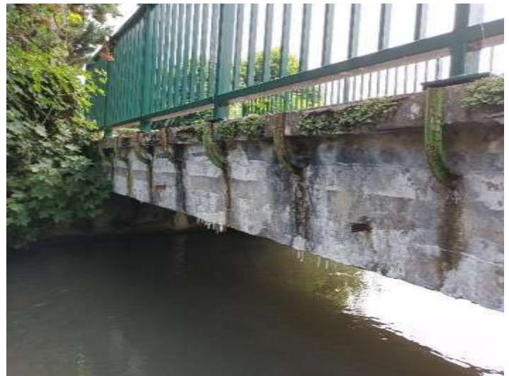
Figure 48 : Poutres en bon état général – présence de stalactites liés à la calcite
