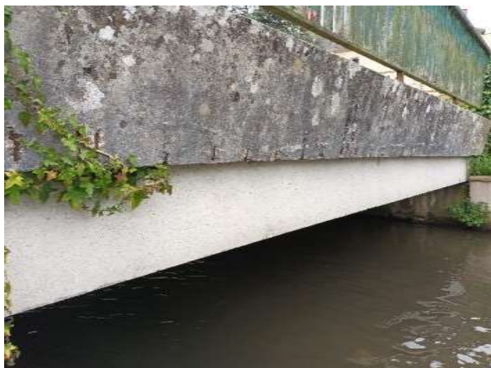
Figure 41 : Tablier en bon état général – présence d'aciers corrodés en rive
