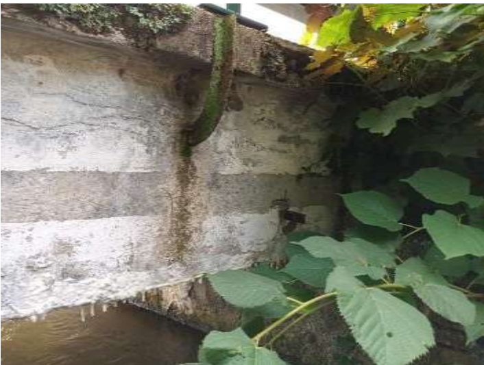
Figure 47 : Poutres en bon état général – présence de stalactites liés à la calcite
