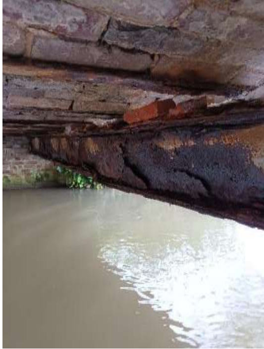
Figure 29 : Voutains brique déformés
