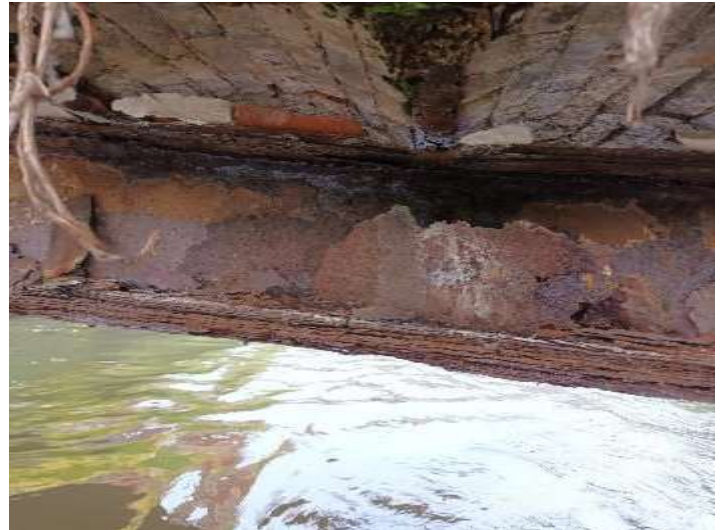
Figure 24 : Profilés fortement corrodés et arrivés à rupture
