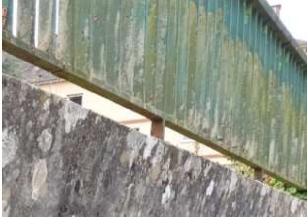
Figure 44 : Garde-corps en bon état – corrosion en pied
