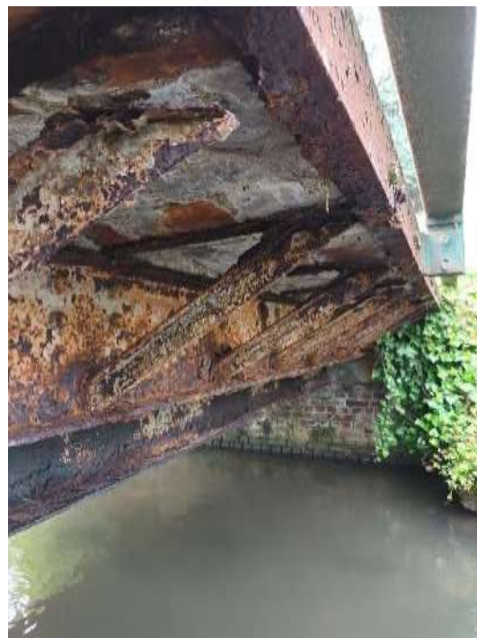
Figure 28 : Profilés fortement corrodés et arrivés à rupture – pièces d’appuis non reliées
