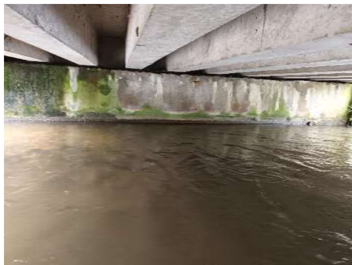
Figure 36 : Piles de passerelle en bon état général – quelques signes de corrosion
