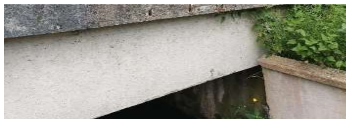
Figure 38 : Poutres de rive en bon état général
