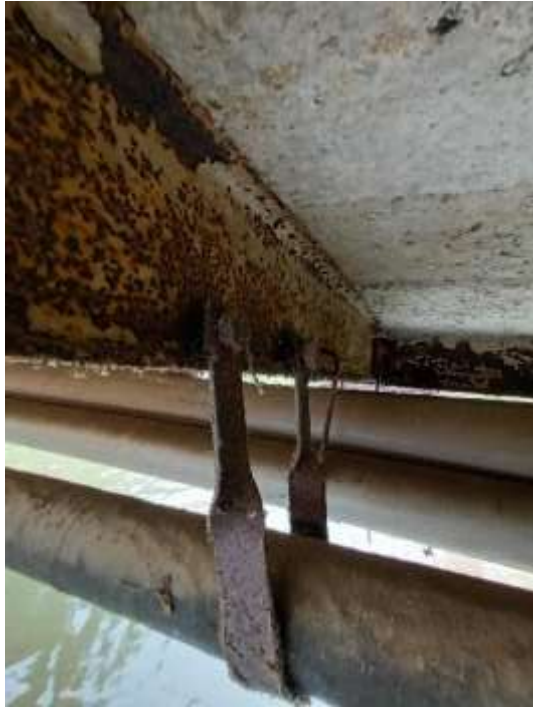
Figure 11 : Profilés corrodés et peinture écaillées
