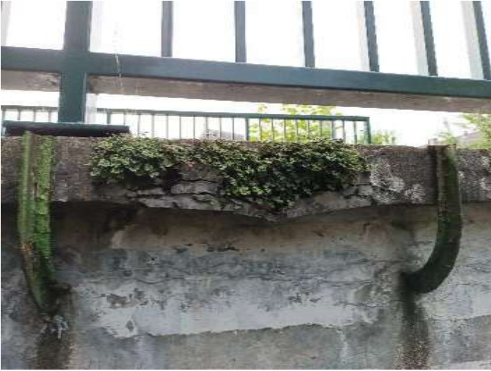
Figure 53 : Rives du tablier dégradées
