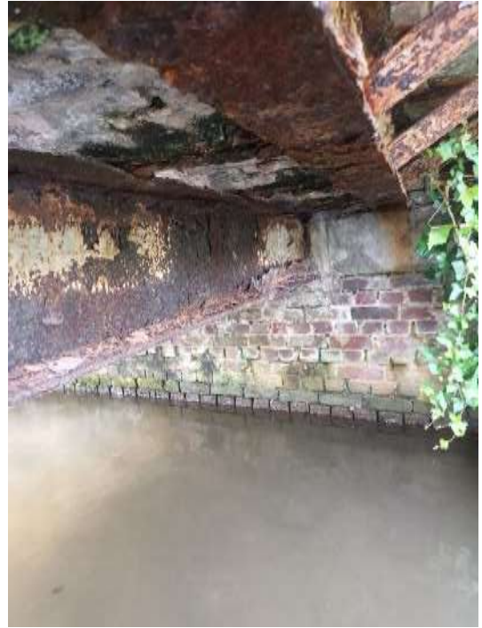
Figure 22 : Piles de passerelle abimées
