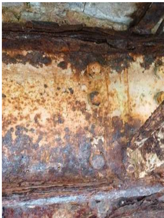
Figure 27 : Profilés fortement corrodés et arrivés à rupture – boulons corrodés
