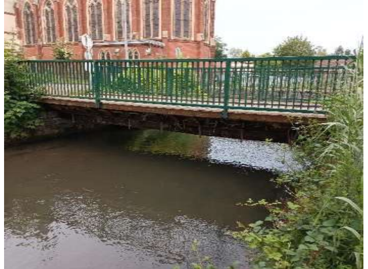
Figure 34 : Garde-corps en bon état
