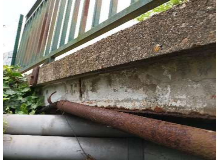
Figure 16 : Signes de corrosion sur le tablier de passerelle
