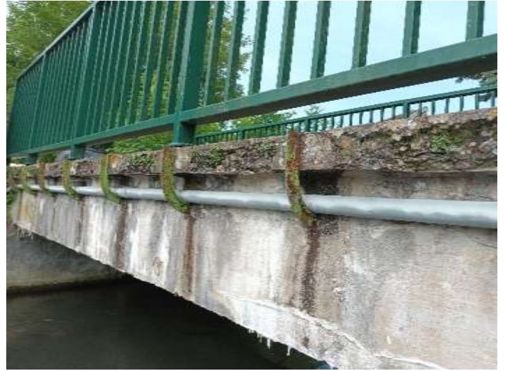
Figure 54 : Rives du tablier dégradées
