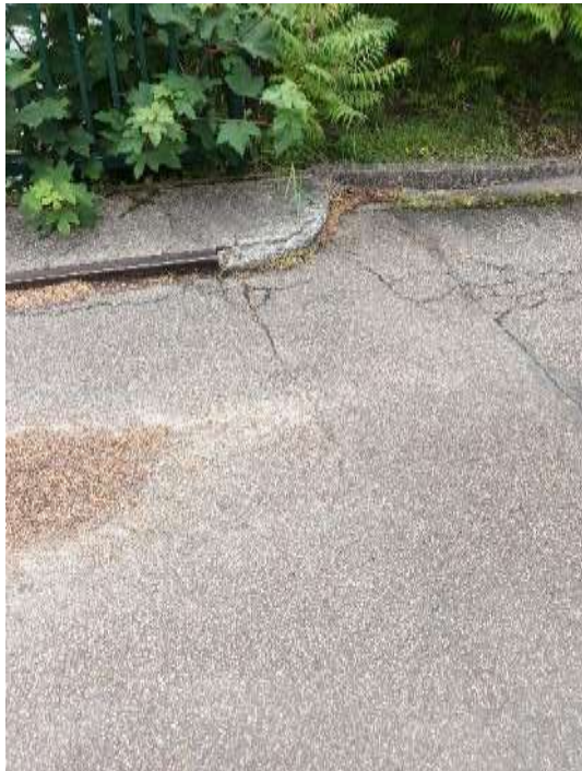
Figure 31 : Signes de déformations sur le tablier de passerelle
