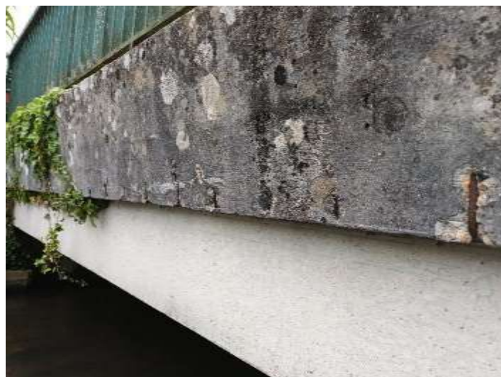
Figure 42 : Tablier en bon état général – présence d'aciers corrodés en rive
